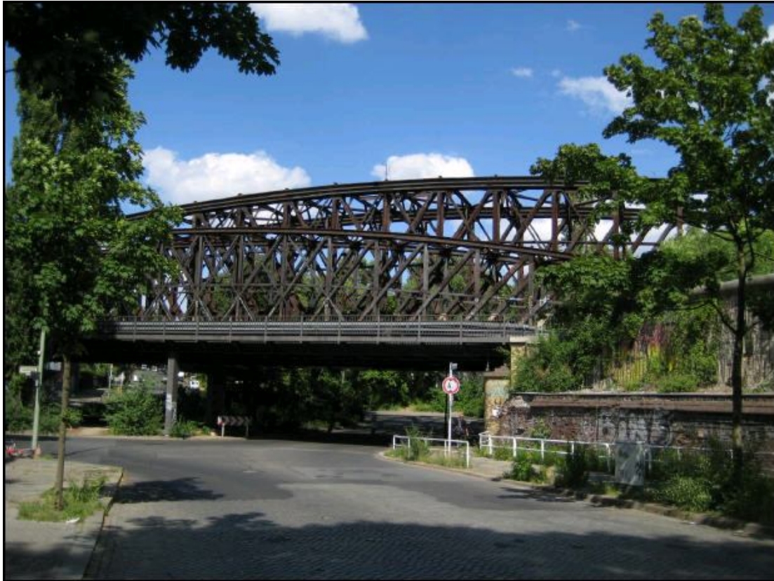
Foto 8: Liesenbrücke von der Liesenstraße aus gesehen. Rechts im Bild sind noch Reste der einstigen Berliner Mauer zu sehen. Quelle: Flanieren-in-Berlin.de (2006)
