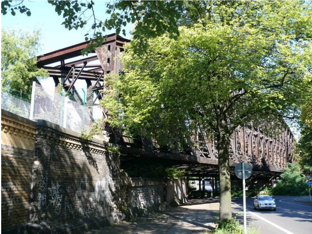
Foto 6: Liesenbrücke von der südlichen Ackerstraße aus gesehen. Im Bild oben links ist der Absperrzaun zu sehen, an dem der Park am Nordbahnhof endet. Quelle: eigene Aufnahme September 2010
