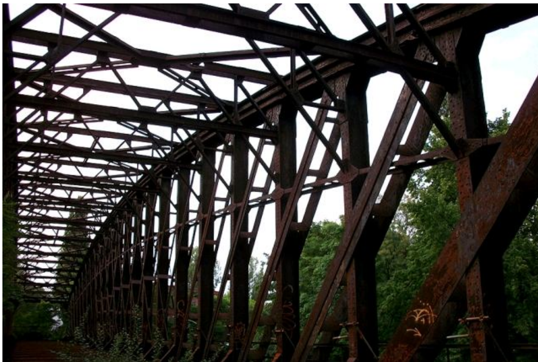
Foto 1: Obergurte in Form einer Halbparabel. Quelle: Spreeufer.com (2012)
