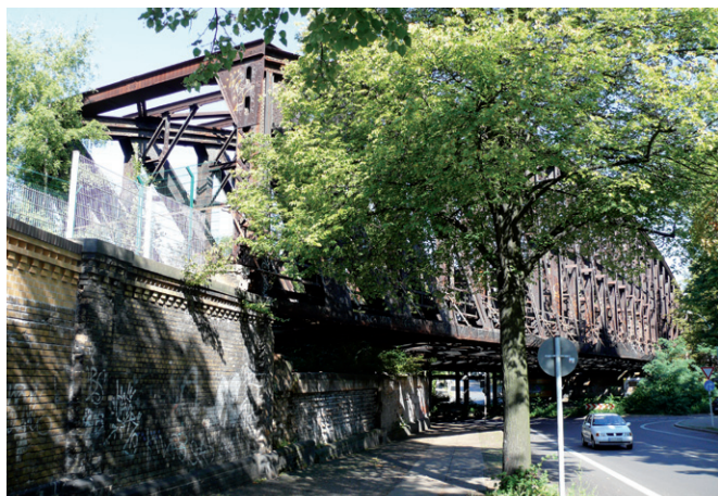
Brücke sucht Sponsor: Liesenbrücke verbindet Parks
